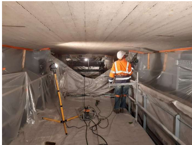
Réparation des bétons dégradés.
