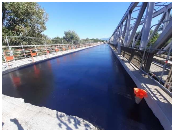
Mise en œuvre du complexe d'étanchéité.
