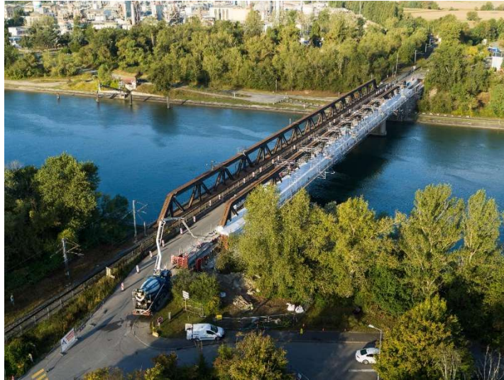
Confinement d'une partie de l'ouvrage pour la reprise du système anticorrosion (crédits photo Arkédia).
