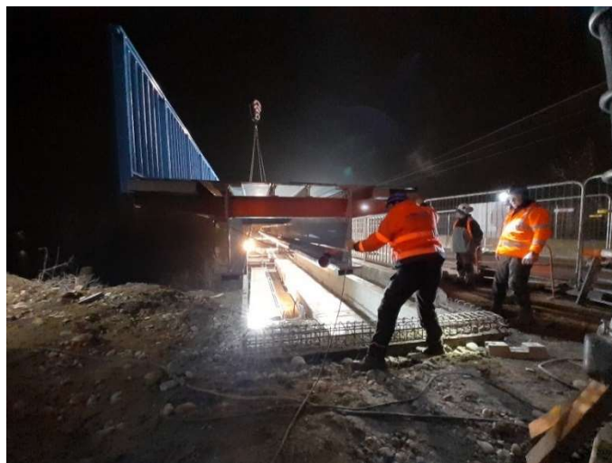
Pose d'une première passerelle piétons/cyclistes fin janvier.
