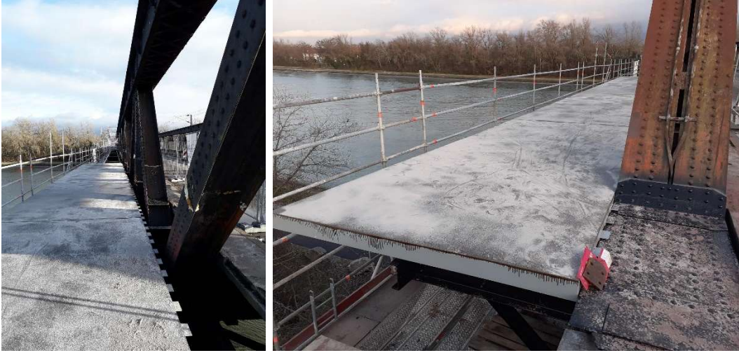
Installation des plateaux métalliques piétons/cyclistes.
