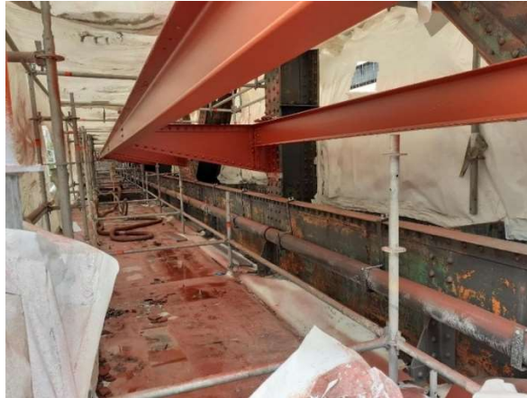
Traitement anticorrosion appliqué sur les appuis des plateaux métalliques.
